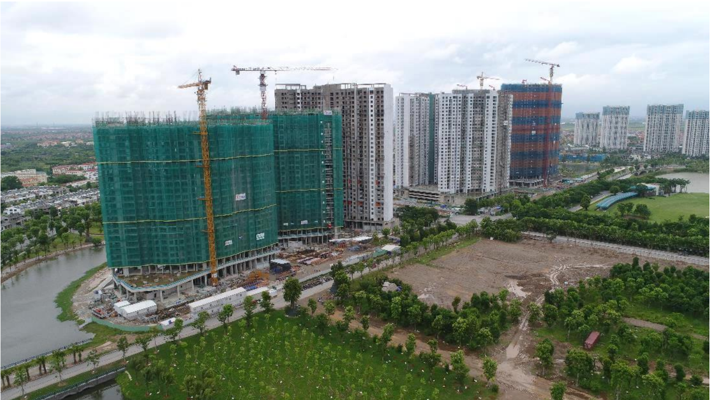
Tháp Park 1 đã đổ sàn tầng 26, tháp Park 2 đã đổ sàn tầng 24.
