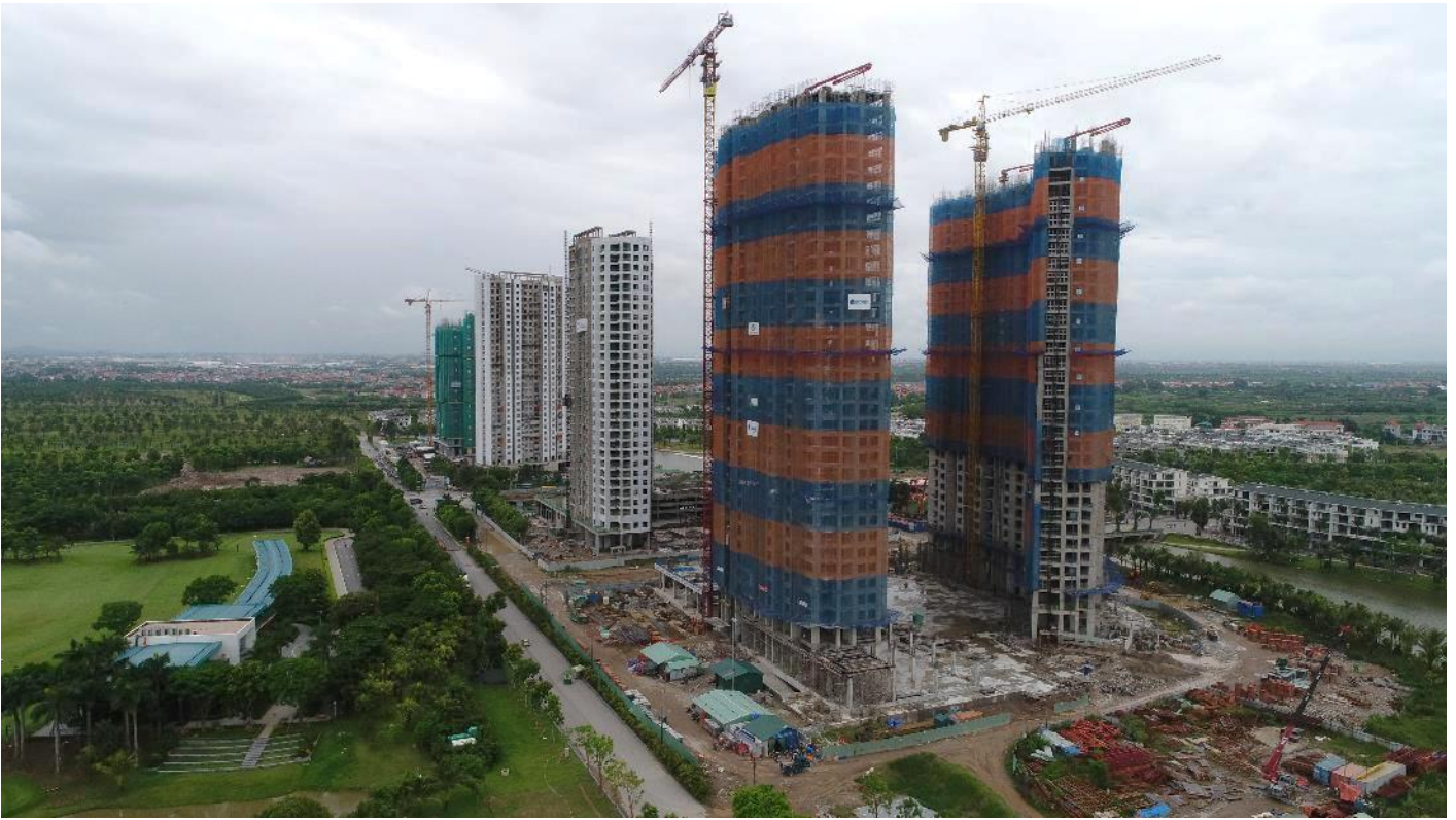
Tháp Lake 1 đã đổ sàn tầng 35, dự kiến sẽ cất nóc vào ngày 05/08/2018. Bên cạnh đó, tháp Lake dự kiến cất nóc 15/08/2018.
