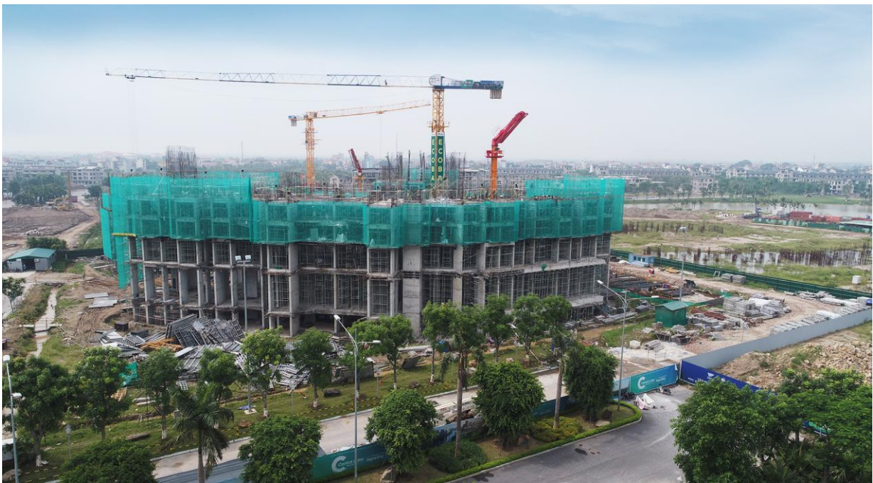
Tháp Sky 2 và Sky 3 đã hoàn thiện tầng 5, chuẩn bị thi công dầm sàn tầng 6, vượt tiến độ đề ra
