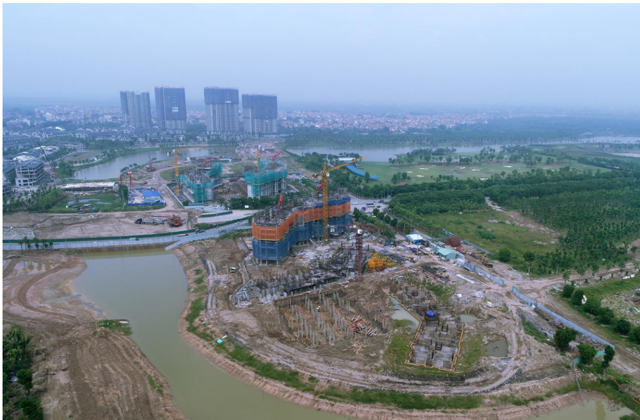
2 tòa Lake 1 và Lake 2 đang tiến hành thi công phần ngầm
