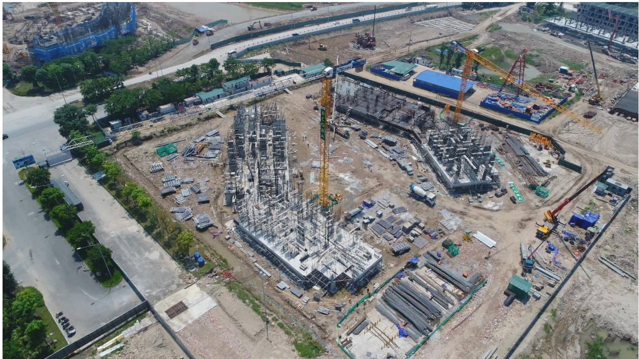
Tháp Sky 1 và Sky 3 đang thi công tầng 2.
