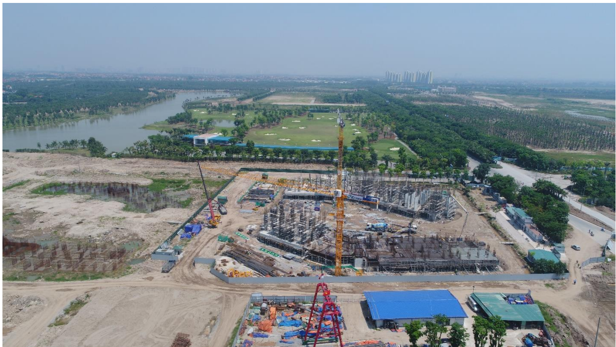
Tháp Sky 2 đã hoàn thiện bê tông dầm sàn tầng 2, đang chuẩn bị thi công cột vách tầng 3, gấp rút hoàn thiện tiến độ để ra tới ngày 10/6 đổ sàn tầng 4.
