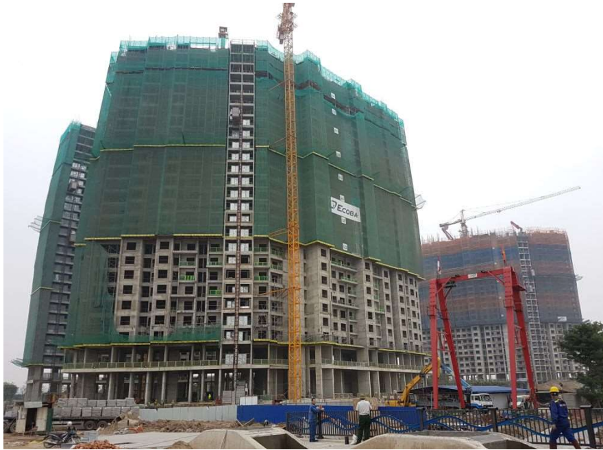
3 tháp Sky đang được xây vượt tiến độ
