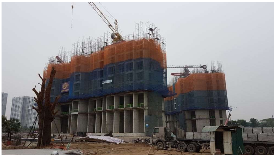
Các tòa Lake đã xây dựng đến hết tầng 7
