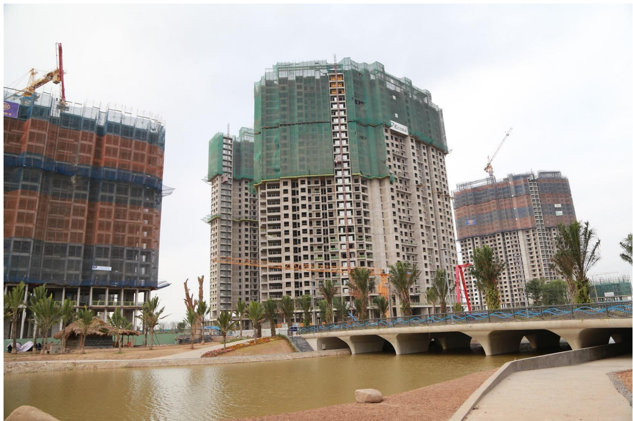
2 tòa căn hộ Lake 1 và Lake 2 đang hoàn thiện đổ sàn tầng 17.
